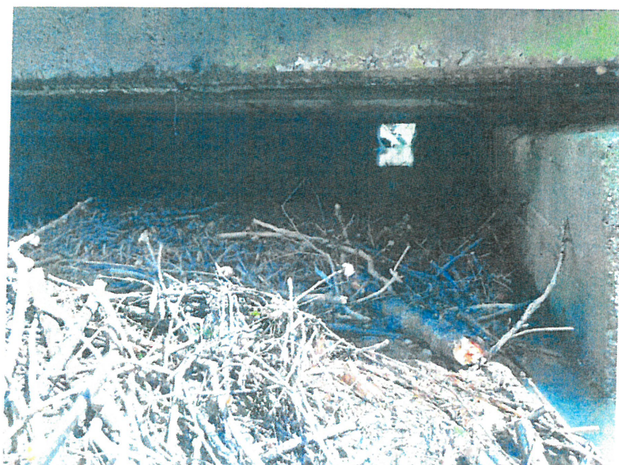
fot. 8 – Widok ogólny części wylotowej przepustu
