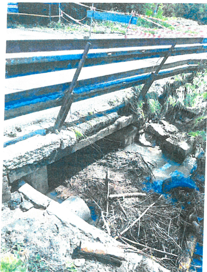
fot. 7 – Wylot przepustu
