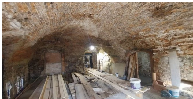
Zdjęcie 7. Realizacja prac budowlanych w Górkach Wielkich
