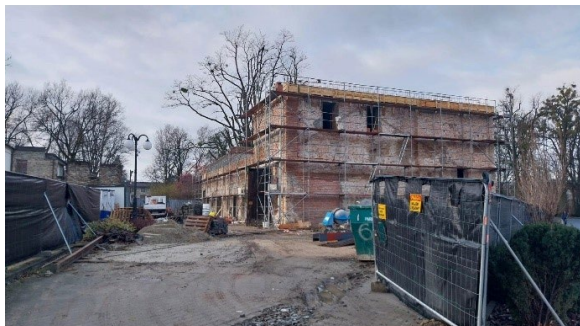
Zdjęcie 6. Realizacja prac budowlanych w Górkach Wielkich
