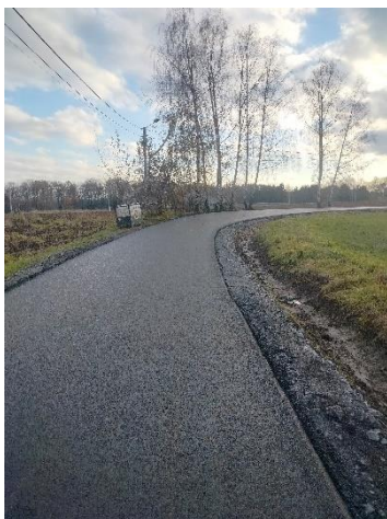
Zdjęcie 74. ul. Graniczna w Kończycach Małych - przebudowa
