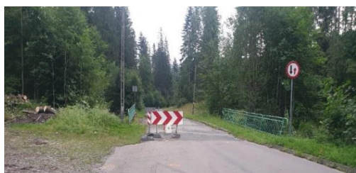
Zdjęcie 53. ul. Dziehcinka w Wiśle przed remontem
