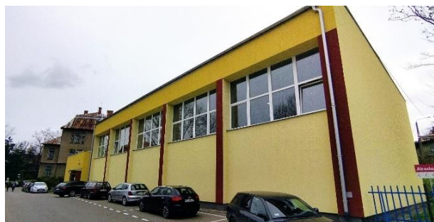
Zdjęcie 7. Hala sportowa przy Zespole Szkół Technicznych im. Gwido Langera w Cieszynie
