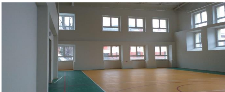
Zdjęcie 42. Hala w budynku ZST w Ustroniu
