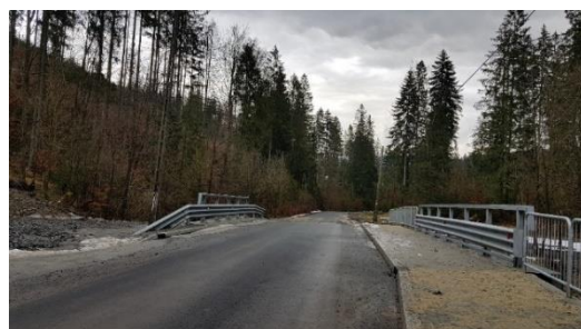
Zdjęcie 54. ul. Dziehcinka po remoncie
