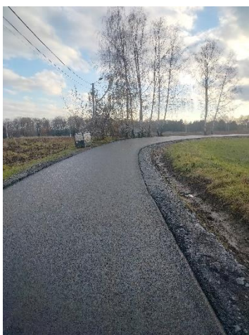
Zdjęcie 74. ul. Graniczna w Kończycach Małych - przebudowa
