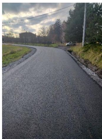
Zdjęcie 75. ul. Graniczna w Kończycach Małych - przebudowa
