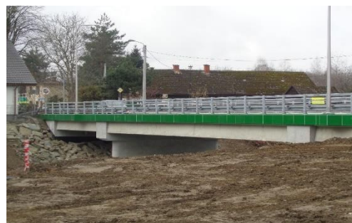
Zdjęcie 58. Nowy most nad rz. Wisłą (2)
