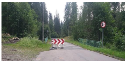
Zdjęcie 53. ul. Dziehcinka w Wiśle przed remontem
