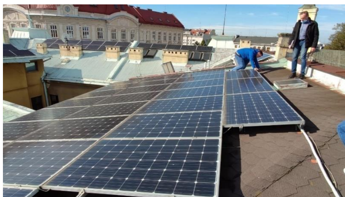
Zdjęcie 44. Modernizacja dachu PDPS „Pogodna Jesień” w Cieszynie
