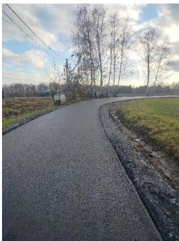
Zdjęcie 74. ul. Graniczna w Kończycach Małych - przebudowa
