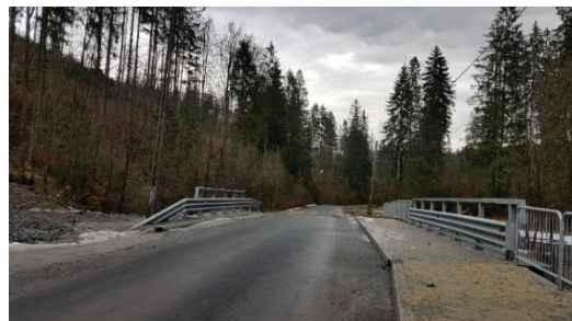
Zdjęcie 54. ul. Dziehcinka po remoncie
