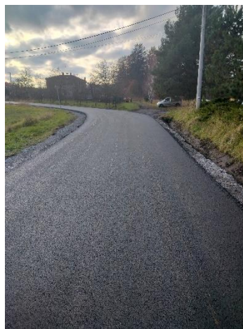
Zdjęcie 75. ul. Graniczna w Kończycach Małych - przebudowa
