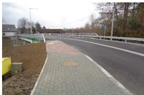
Zdjęcie 56. Nowy most nad rz. Wisłą (1)
