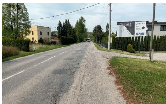
Zdjęcie 59. Droga powiatowa ul. Breńska w Górkach Małych (1) (przed)
