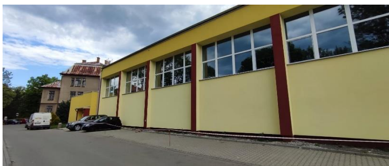
Zdjęcie 40. Hala sportowa przy ZST w Cieszynie
