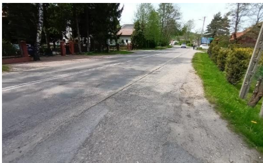
Zdjęcie 61. Droga powiatowa ul. Breńska w Górkach Małych (2) (przed)
